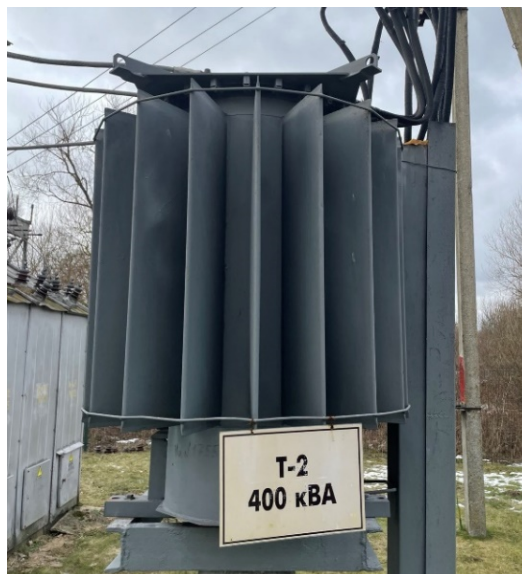
Рисунок 1 – Изображение силового трансформатора ТМГ-400/10/0,4
